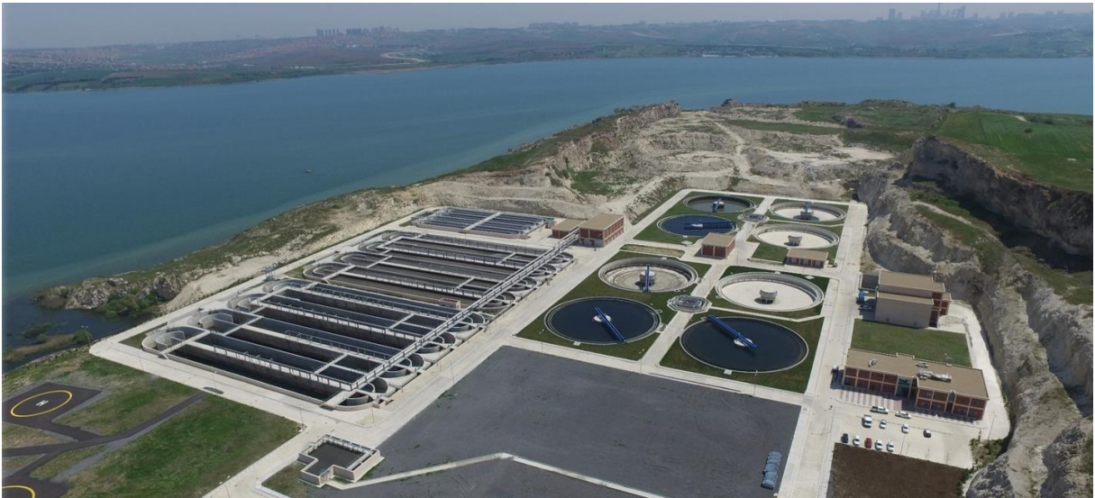
Şekil 20 Büyükçekmece İleri Biyolojik Atık Su Arıtma Tesisi
