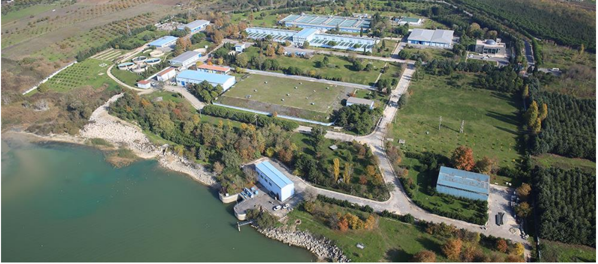
Şekil 19 Büyükçekmece İme Suyu Arıtma Tesisi
